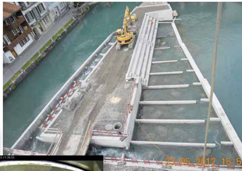
oben: Fischpass Mühleschleuse während des Baus im Mai 2012
